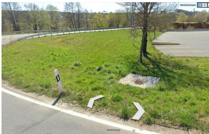
Mündung der Entwässerung des potenziellen Fließwegs bei Starkregen auf der zum Ebrachtal gewandten Seite der Staatsstraße (Foto: Google Street)
